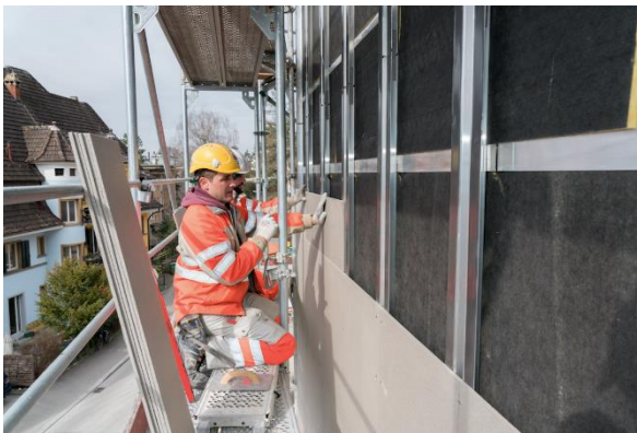
Un travail dans les hauteurs : la pose des panneaux supports d'enduit MARMOtec. © 2018 Saint-Gobain ISOVER SA (DSC00907.jpg)
