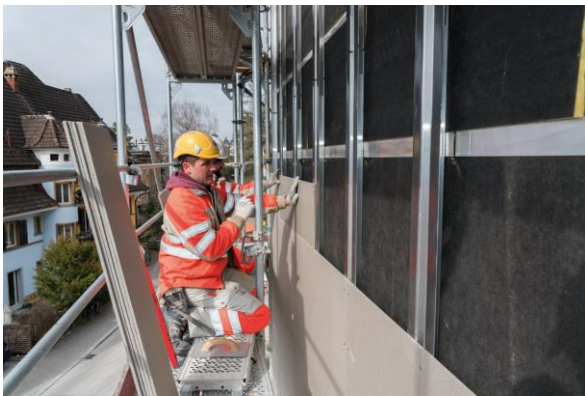
Arbeit in luftiger Höhe: Die Montage der MARMOtec Putzträgerplatten © 2018 Saint-Gobain ISOVER AG (DSC00907.jpg)
