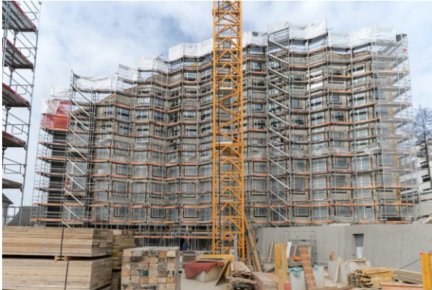
Eine Fassade mit vielen Ecken und Kanten. © 2018 Saint-Gobain ISOVER AG (RBA07892-2.jpg)
