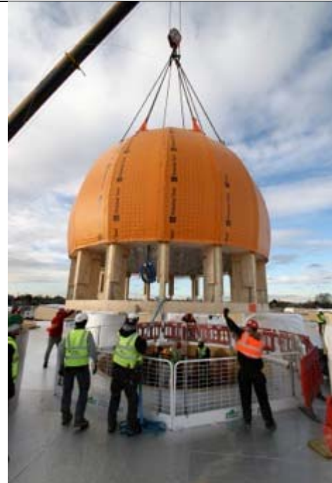
Un grand moment des travaux : le montage de la coupole haute de neuf mètres. © Blumer-Lehmann AG
