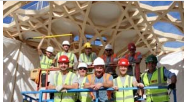
L'équipe de montage de Blumer-Lehmann sur le chantier. Le montage des éléments en bois a duré près de six mois. ©Blumer-Lehmann AG
