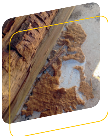
Poutre de toiture attaquée par un champignon lignivore.
