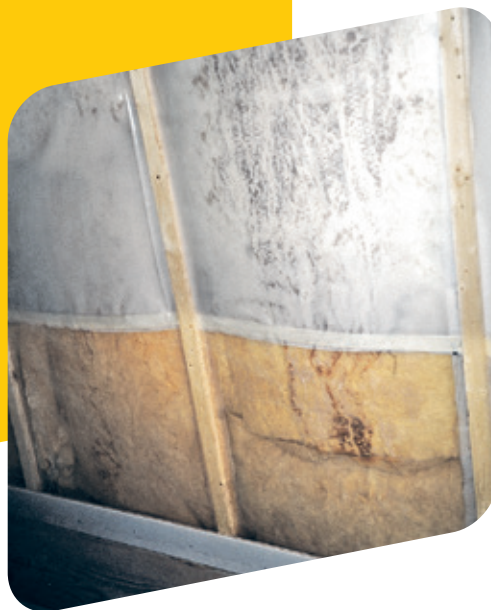
Dégradations provoquées par la mise en place de bois humide en association avec un pare-vapeur traditionnel.
