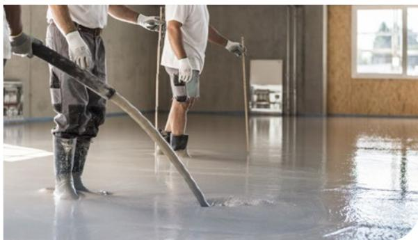
Composition\* avec une chape fluide à base de sulfate de calcium de 55 mm :
