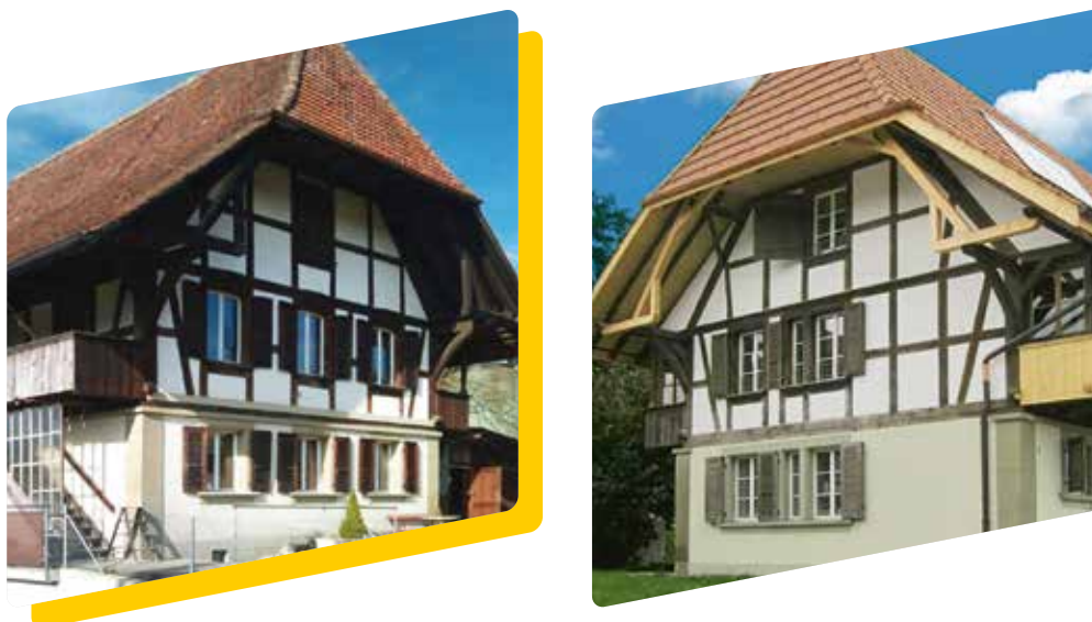
Fig. 20 : Construction à colombages Buchweg 7 à Berne, réalisation de l'isolation intérieure : Gerber Holzbau Bern AG, Oberbottigen
