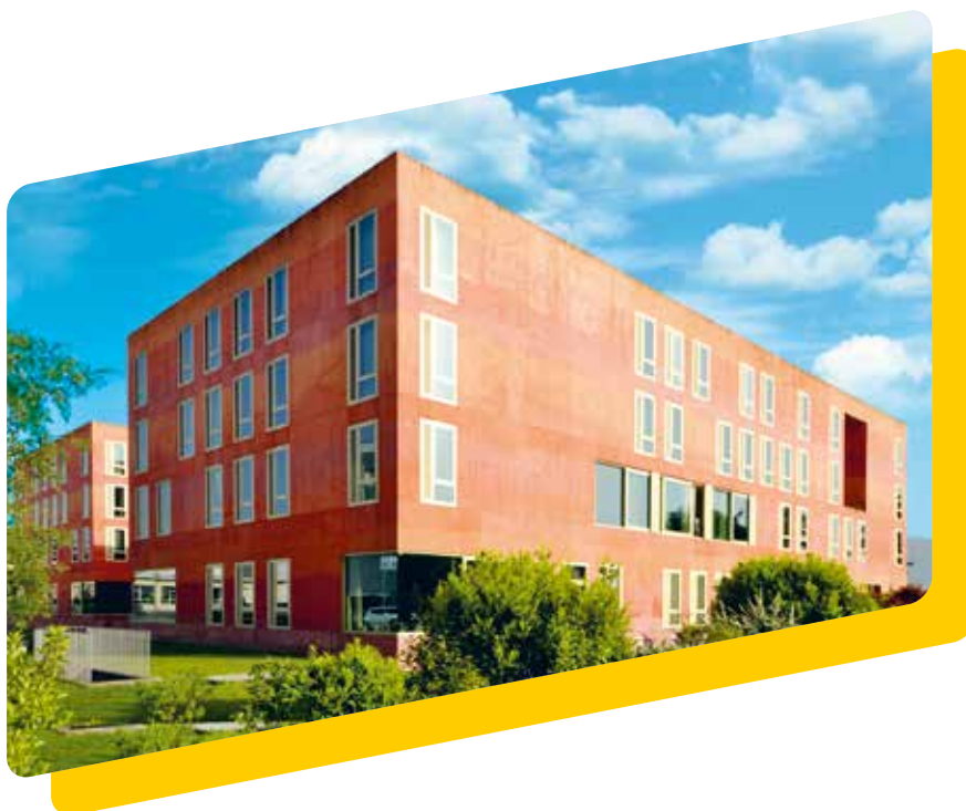
Fig. 19 : Béton apparent coloré, psychiatrie d'Yverdon, réalisation de l'isolation intérieure : Sauteur Georges SA, La Tour-de-Tréme
