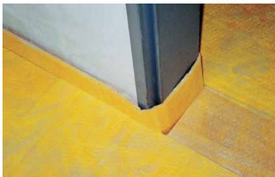
Panneau d'isolation contre les bruits solidiens PS 81 pour chapes sans chauffage au sol
