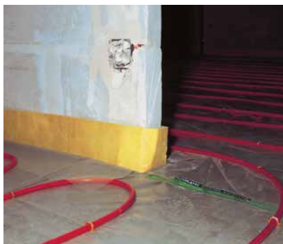
Isolation contre les bruits solidiens ISOCALOR pour chapes avec chauffage au sol, y compris bandes de rive FS
