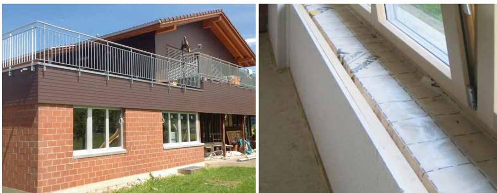
Fig. 20: Maçonnerie en briques apparentes maison d'habitation à Kägiswil, planification et exécution de l'isolation intérieure: Holzbau Bucher AG à Kerns, pour plus d'informations, voir le dépliant «Isolation intérieure – Isolation optimale avec de la laine de verre suisse»
