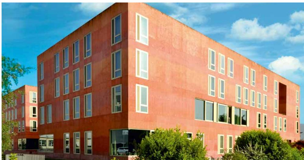
*Fig. 18: Béton apparent coloré, psychiatrie Yverdon, exécution de l'isolation intérieure: Sauteur Georges SA, La Tour-de-Trême*
