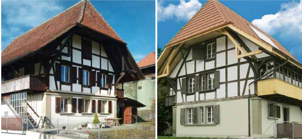
Fig. 19: Construction en pans de bois Buchweg 7 à Berne, exécution de l'isolation intérieure: Gerber Holzbau Bern AG à Oberbottigen
