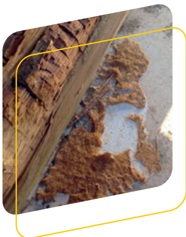
Dachbalken mit Schimmelbefall.
