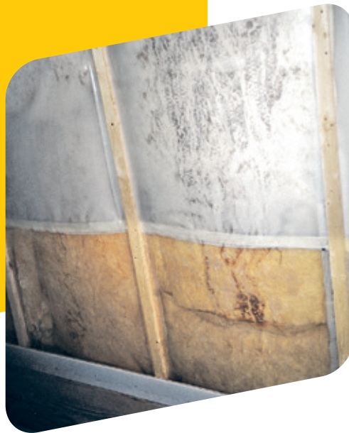
Schäden durch Einbau von feuchtem Holz in Kombination mit einer herkömmlicher Dampfbremse.
