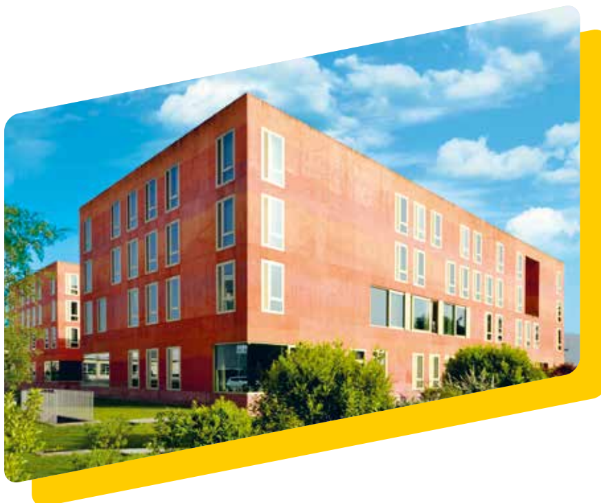
Abb. 19: Sichtbeton eingefärbt, Psychiatrie Yverdon, Ausführung Innendämmung: Sauteur Georges SA, La Tour-de-Trême
