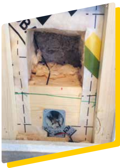
Abb. 22: Ausbau der Messsonden im Objekt «Brütteln» (siehe Seite 30) nach dem vierten Winter: Es kann kein Schimmel-pilzwachstum festgestellt werden. Die Isover-Glaswolle weist weder in der Form noch optisch Veränderungen auf.
