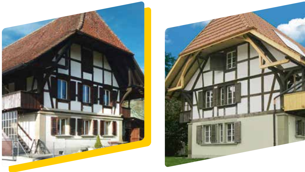
Abb. 20: Fachwerkbau Buchweg 7 in Bern, Ausführung Innendämmung: Gerber Holzbau Bern AG, Oberbottigen
