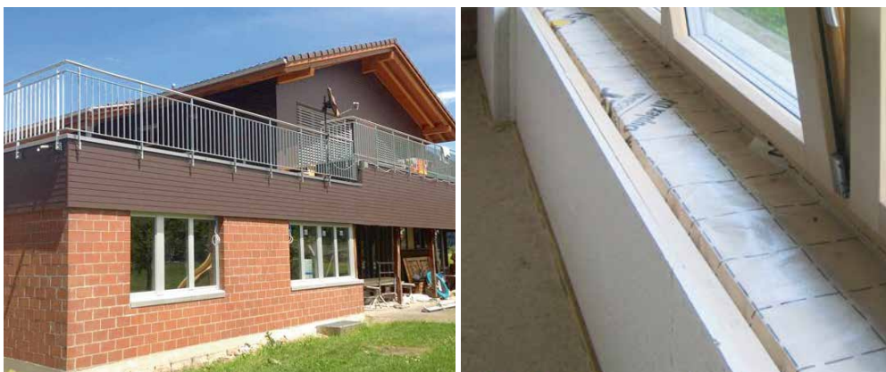
Abb. 20: Sichtmauerwerk Wohnhaus in Kägiswil, Planung und Ausführung Innendämmung: Holzbau Bucher AG, Kerns, weitere Informationen siehe Faltblatt «Innendämmung – Optimal gedämmt mit Schweizer Glaswolle»
