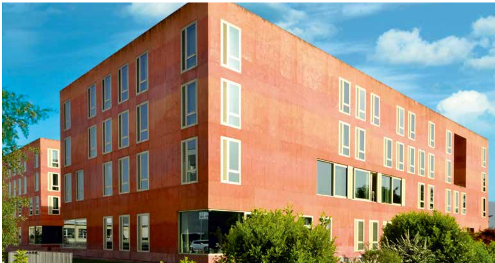
Abb. 18: Sichtbeton eingefärbt, Psychiatrie Yverdon, Ausführung Innendämmung: Sauteur Georges SA, La Tour-de-Trême
