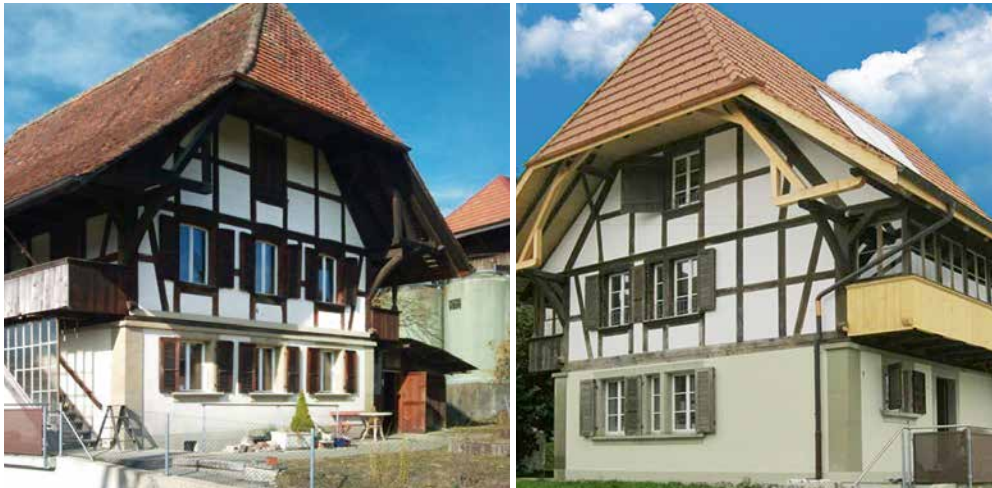
Abb. 19: Fachwerkbau Buchweg 7 in Bern, Ausführung Innendämmung: Gerber Holzbau Bern AG, Oberbottigen
