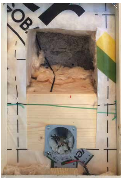
Abb. 21: Ausbau der Messsonden im Objekt «Brüttelen» (siehe Seite 30) nach dem vierten Winter: Es kann kein Schimmelpilzwachstum festgestellt werden. Die ISOVER-Glaswolle weist weder in der Form noch optisch Veränderungen auf.
