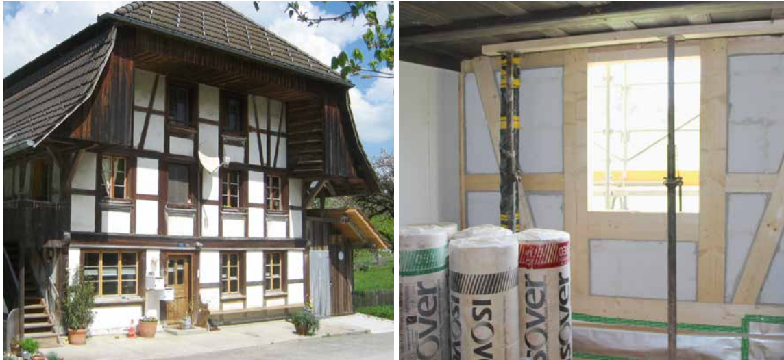
Planung und Zimmerarbeiten: Remund Holzbau, Schwarzenburg
