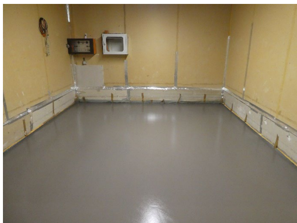
Abbildung 1 Der noch feuchte Zementdünnestrich im Prüfraum 12.
